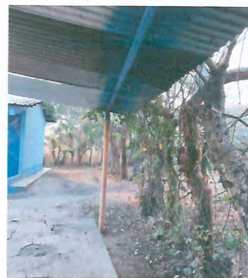
Foto 2: MEJORAMIENTO DE CERRAMIENTO DE MURO PERIMETRAL.
